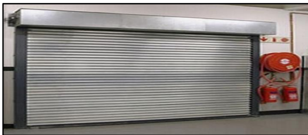
Satu Unit Roller Shutter yang terdapat di HCTM
